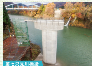
第七只見川橋梁
